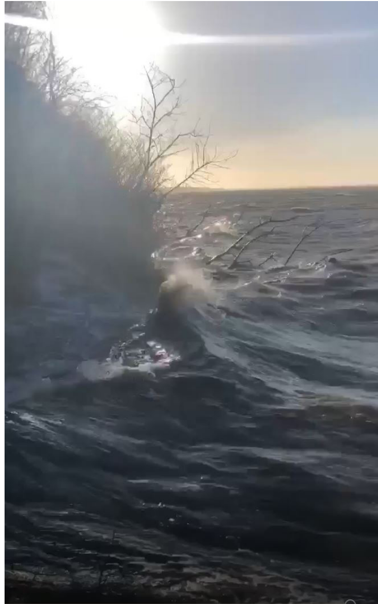
Figur nr. 6 viser at fjordvandet og bølgerne slår direkte ind på skrænten ved Priorbakken 4 (naboejendom), her fotograferet under stormen Malik 29-30. Januar 2022.
